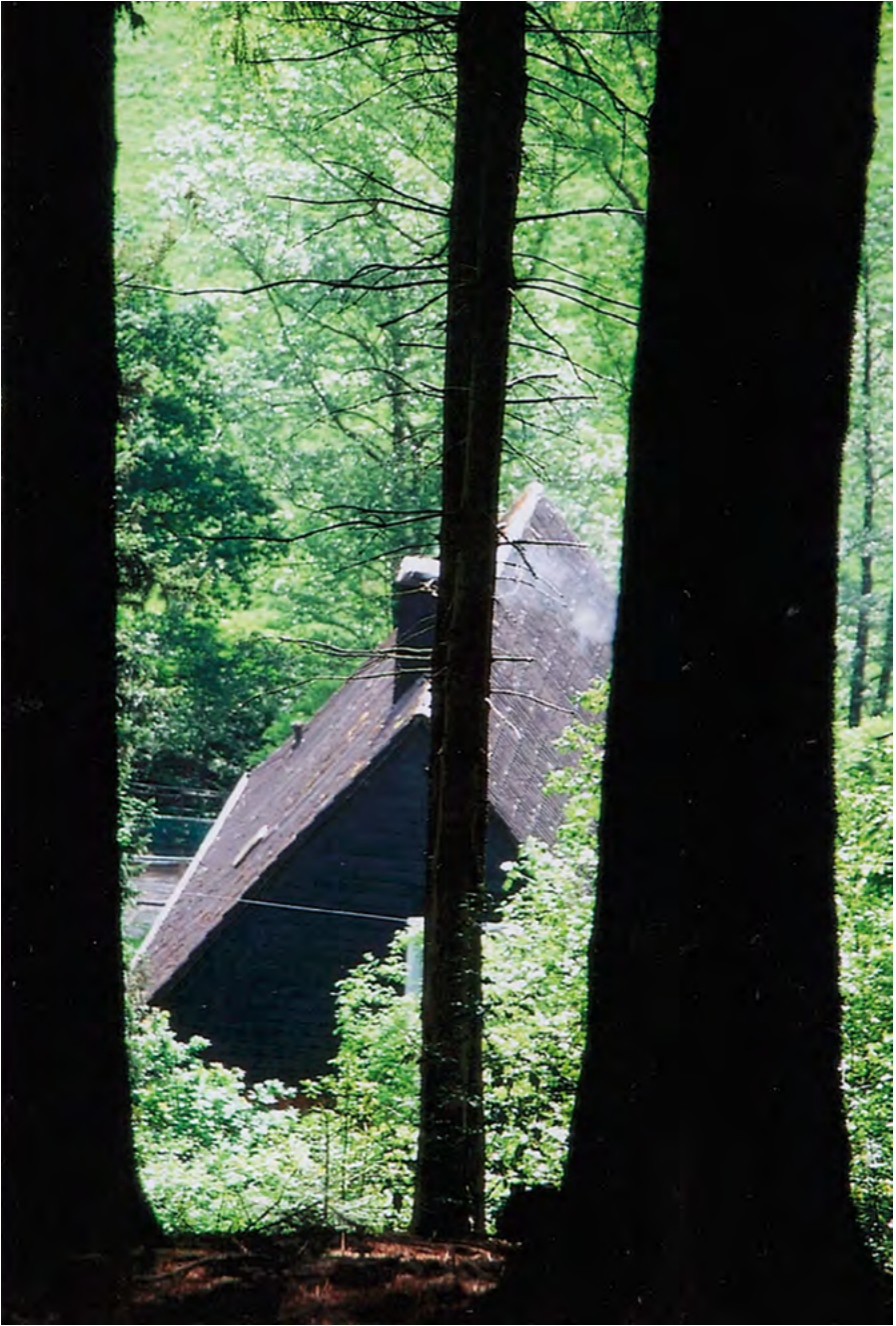
Abb. 4: Ehemalige Bandwirkerwerkstatt In der Espe 21 (Blick von STO 9 auf STO 9x) (Foto: R. GAIDA)
