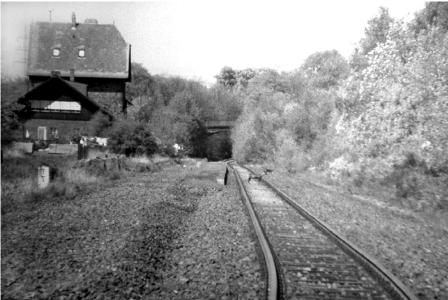
Abbildung 15: Stillgelegtes Bahngelände am alten Bahnhof Schee im Nordosten von Wuppertal, Mai 1990
