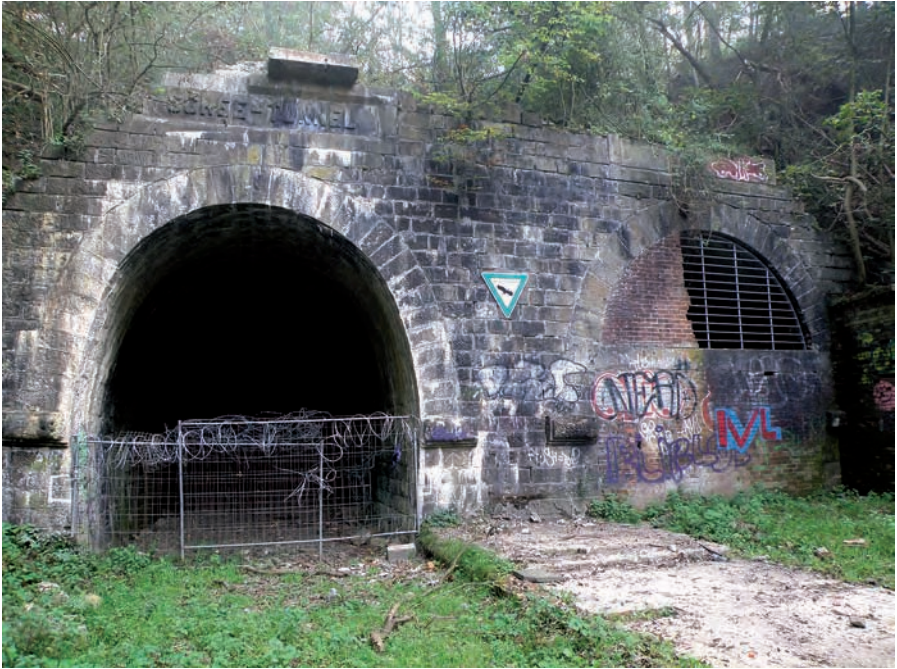
Abb. 7: Südportale an den 2 Röhren vom Tunnel Schee. Das linke Gitter wurde auf der rechten Seite aufgeschnitten 3.10.2011.
