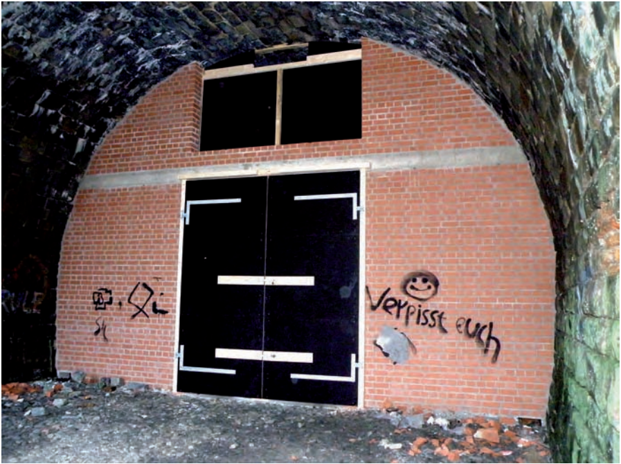
Abb. 3: Ostportal des Tunnels Tesche am 2.10.2011.
