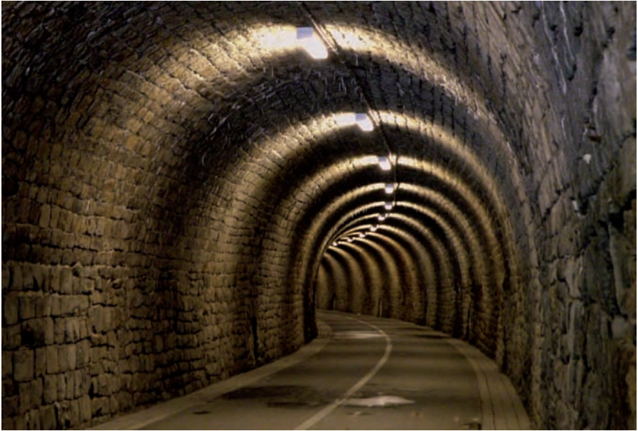
Abb. 11: Tunnel Schulenberg mit der zurzeit ständigen Beleuchtung 6.9.2010.
