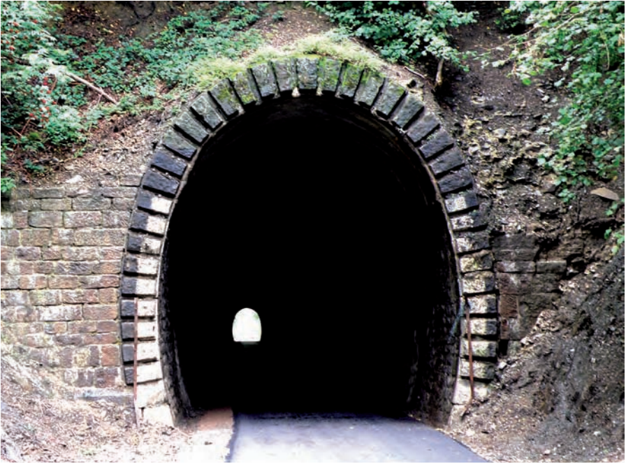
Abb. 14: Zugang zum südwestlich gelegenen Portal des Tunnels Höhsiepen 29.7.2011
