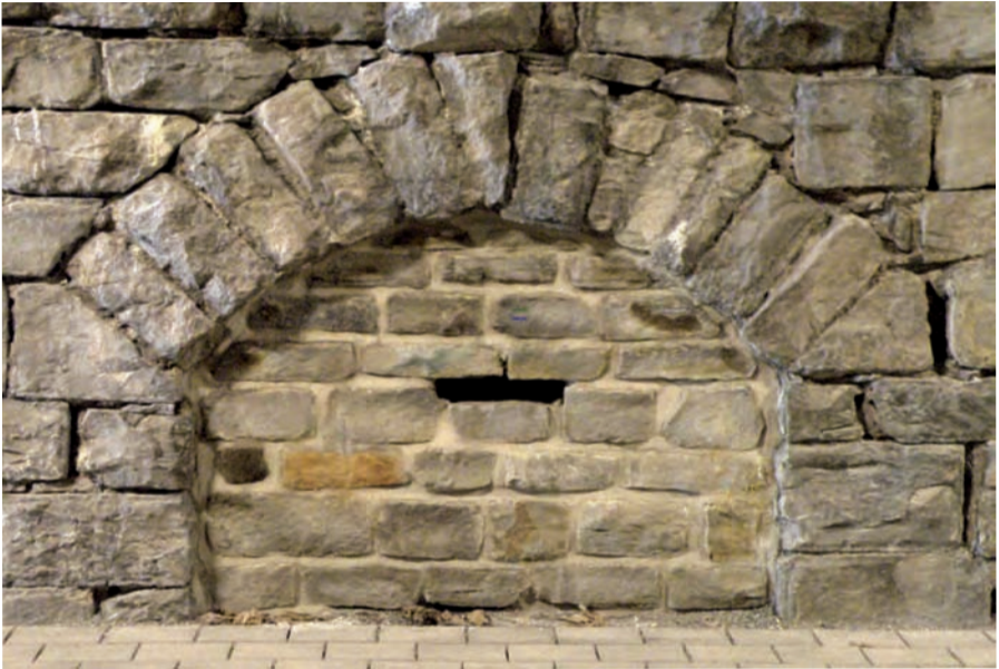
Abb. 12: Kleine Einflugmöglichkeit für Fledermäuse an den Nischen des Tunnels Schulenberg 6.9.2010.
