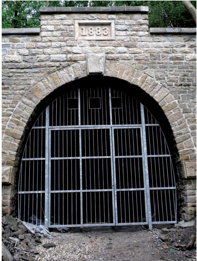
Abb. 13: Geschlossenes südliches Portal des Tunnels Schulenberg. 19.7.2008
