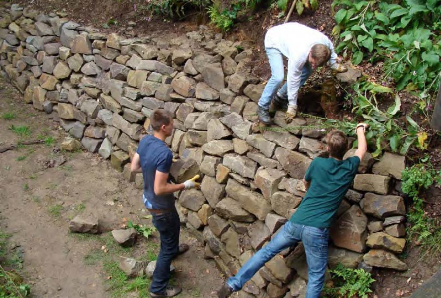
Abb. 9: Gefördert durch die Michael-Otto Stiftung errichtet die Wuppertaler Jugendgruppe BUNDSpechte im Jahr 2014 eine Natursteinmauer im Teichgelände zur Optimierung der terrestrischen Habitate für Alytes obstetricans
