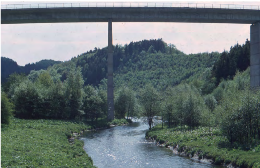
Abb. 8: Neue Kräwinkler Brücke der B 229 bei Krebsöge, Flussaue vor Beginn der Dammbauarbeiten. Foto: R. Mönig, Wuppertal.
