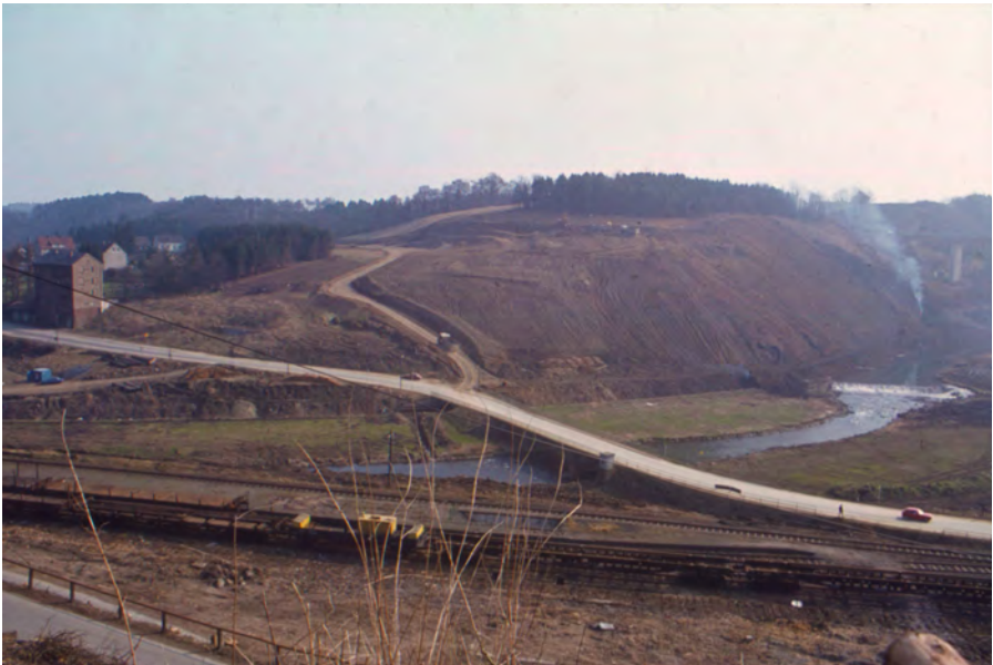
Abb. 11: Geräumtes Baufeld Krebsöge vor Errichtung des Talsperrendammes; Wehranlage/Schlacht zum ehem. Obergraben, Talbrücke B 229 im Bild rechts oben. Foto: R. Mönig, Wuppertal.
