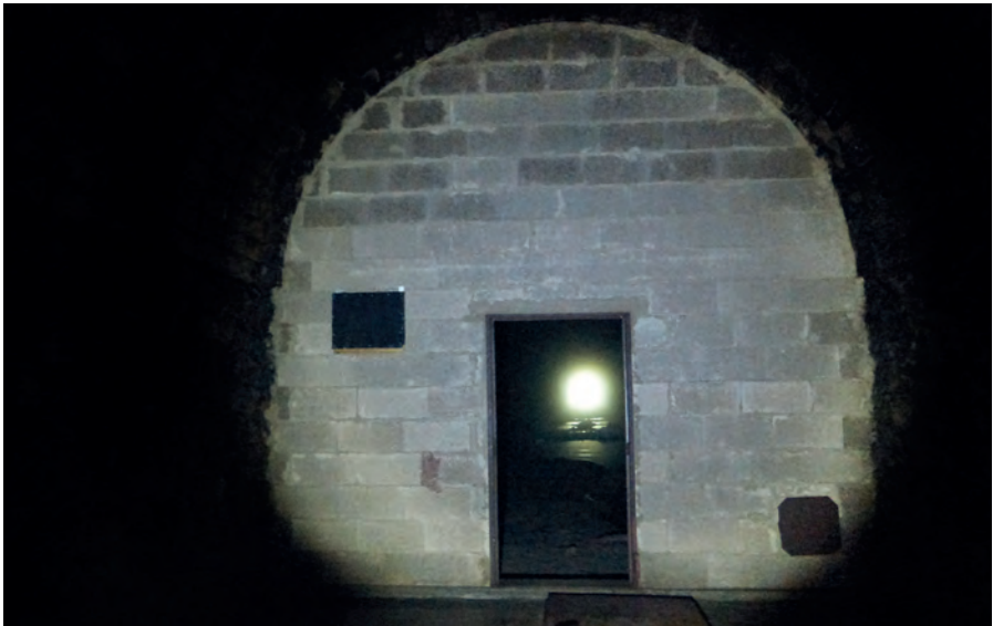
Abb. 1 oben und Abb. 2 unten: Das westliche Tunnelportal und die errichtete Zwischenwand (Fotos: T. Kordges)
