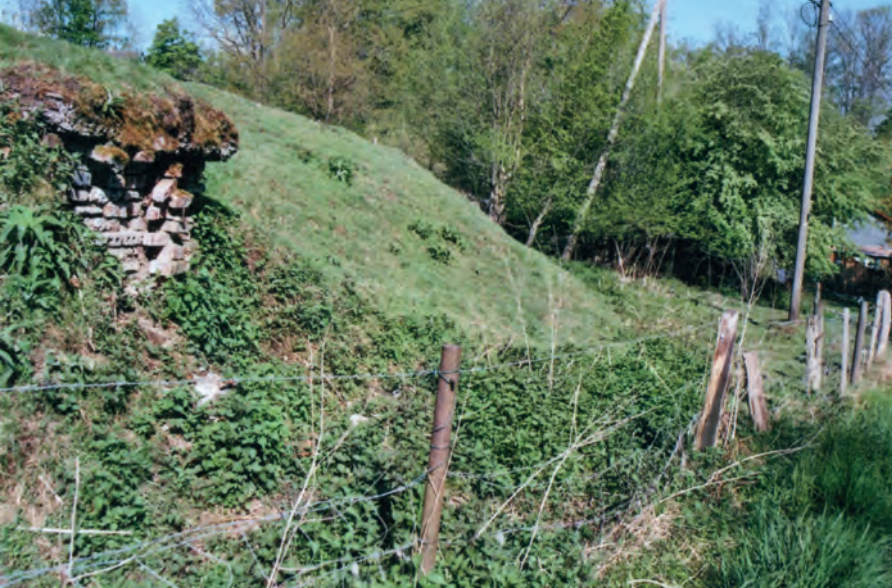
Abb. 5: Luftschutzstollen (links) und Obergraben (vorne links und Mitte) vom Schleifkotten Nippus (STO 1 und STO 2, FOTO: R. GAIDA 2022)
