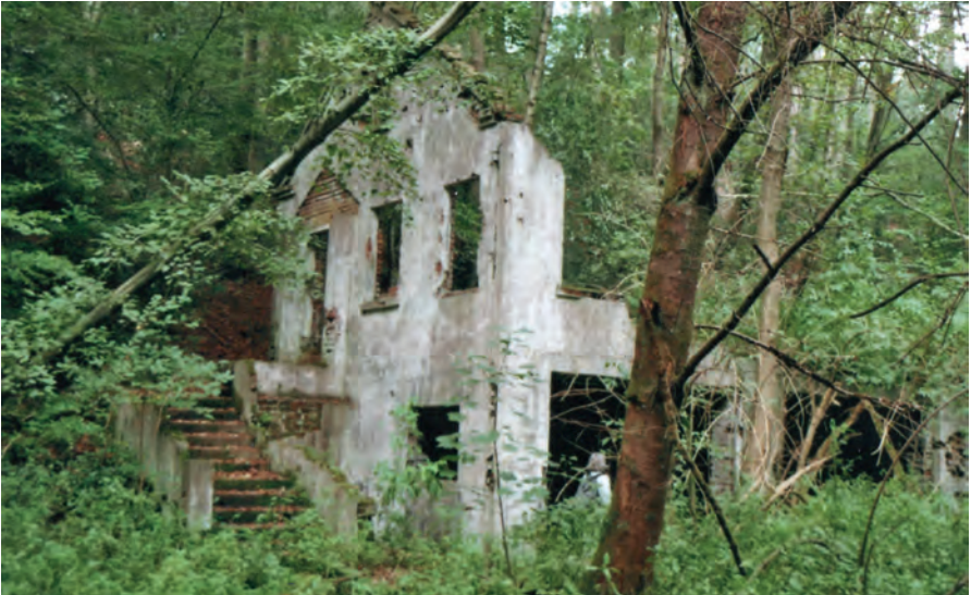
Abb. 32: Blick auf das Hauptgebäude von Elisabethenglück (STO 65, FOTO: R. GAIDA 2022)
