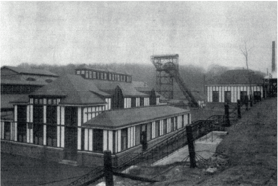
Abb. 16: Blick auf den zentralen Teil von Glückauf Barmen zur Betriebszeit (STO 26, aus: ERBERICH 1911a: 96). Links im Vordergrund ist die große Waschkaue, in der Mitte dahinter den Förderturm, rechts im Hintergrund das Fördermaschinenhaus. Im Vordergrund rechts ist die erhaltene Treppe zu erkennen (siehe Abb. 15).
